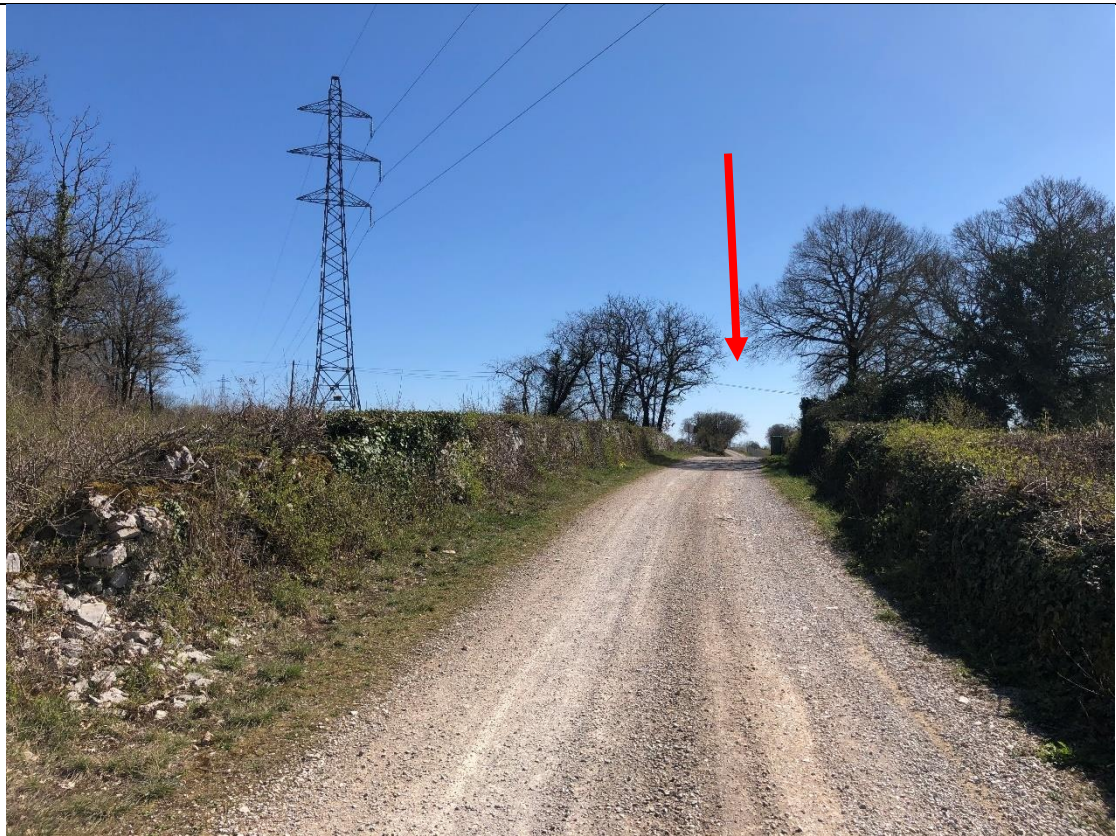
Vue au sol - Photo n°2
